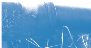
FLAGRANTE DE LIGAÇÕES CLANDESTINAS EM ADUTORA
