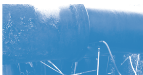
FLAGRANTE DE LIGAÇÕES CLANDESTINAS EM ADUTORA
