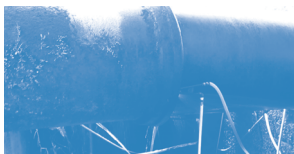
FLAGRANTE DE LIGAÇÕES CLANDESTINAS EM ADUTORA
