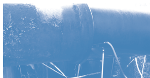
FLAGRANTE DE LIGAÇÕES CLANDESTINAS EM ADUTORA
