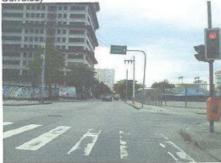
Logradouro e prédio comercial em construção (muito lenta) ao lado do terreno avaliando
