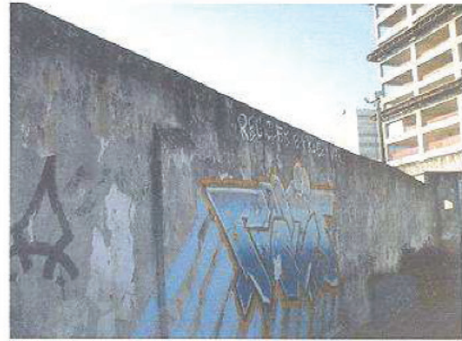
Muro (ao fundo prédio em construção-terreno vizinho)
