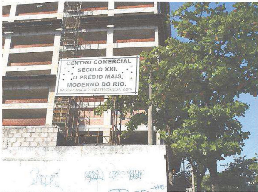
Construção em terreno vizinho Prédio coml com loja e 17 pavimentos tipo e subsolo com 5 pavimentos de garagens
