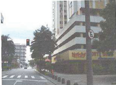
Prédio Residencial (frontal ao prédio dos Correios)
