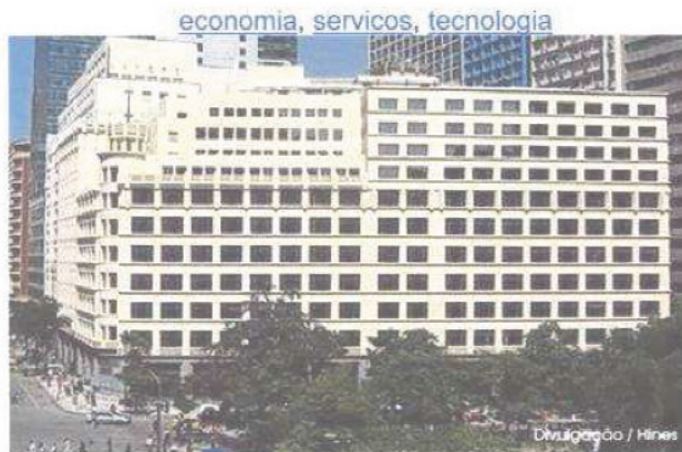
Edifício Castelo, Centro do Rio de Janeiro-RJ
