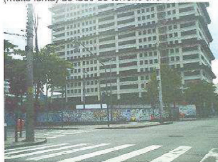
Outra vista do prédio em construção Esquina do terreno avaliando
