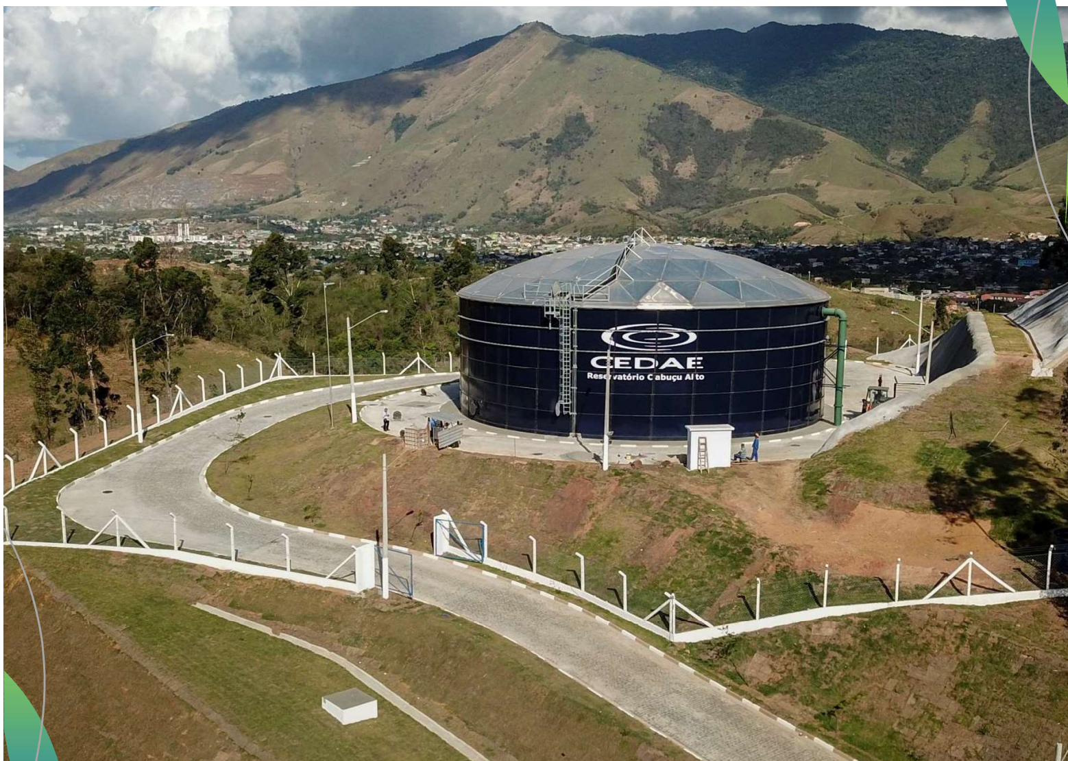
Reservatório Cabuçú Alto
